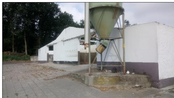
Figuur 6. Buitenzijde paardenstallen achter woning
