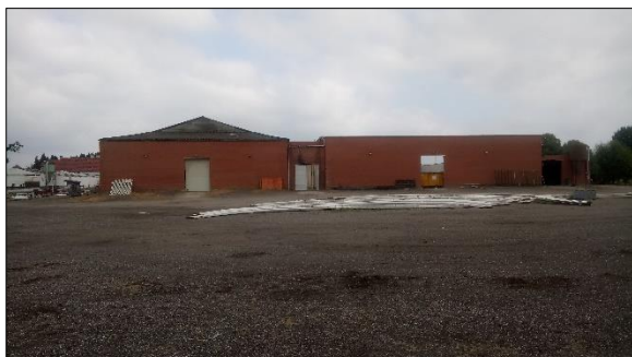
Figuur 5. Achterzijde voormalige manege (rijstallen)
