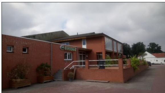
Figuur 3. Voorzijde voormalige manege (kantine)
