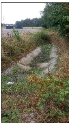
Figuur 13. Zuidelijk gelegen wateropvang
