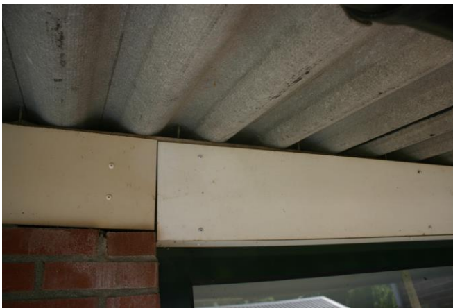
Figuur 4.2.1. De ruimte tussen de golfplaten en het plafond op gebouw 2 (zie figuur 3.1.1) is te ruim en tochtig om als vleermuizenverblijf te kunnen dienen.
