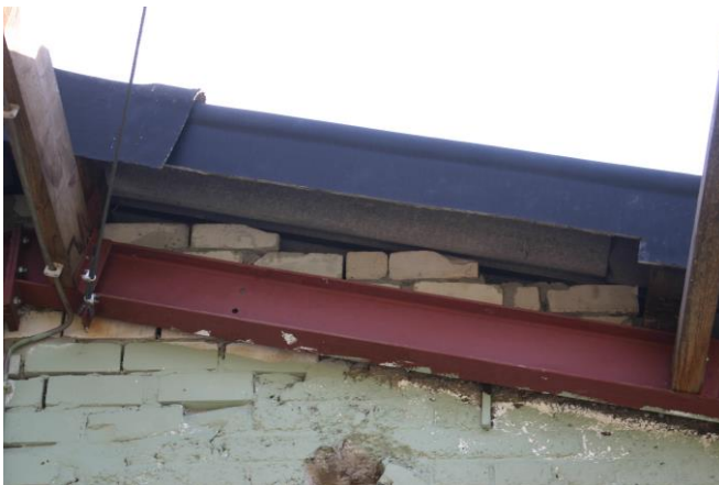
Figuur 4.2.2. De spouw van de westgevel van gebouw 2 (zie figuur 3.1.1) ligt van boven open.
