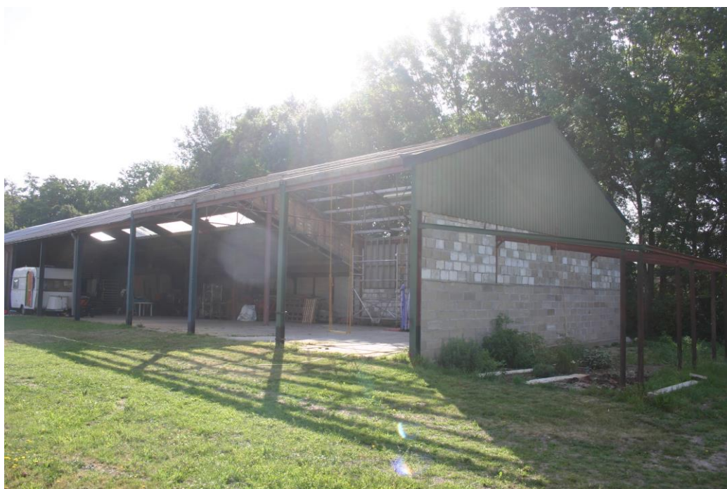
Figuur 4.1.2. Van gebouwen 8 en 9 zijn de asbesthoudende daken recent verwijderd.
